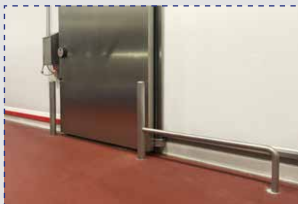
PolySto inox stootpalen -en beugels verankerd in de betonvloer.
